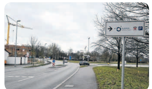
An der Kreuzung Krumenauer Straße / Gerolfinger Straße entsteht ein Kreisverkehr.
