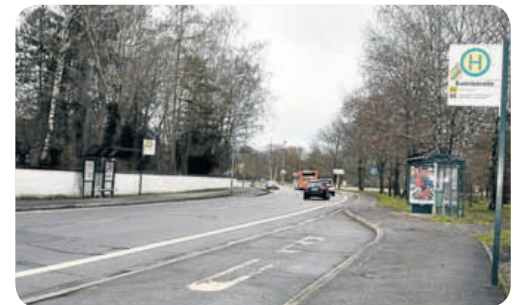
Die Haltestelle „Sustrisstraße“ wird zur Busbucht umgebaut.
